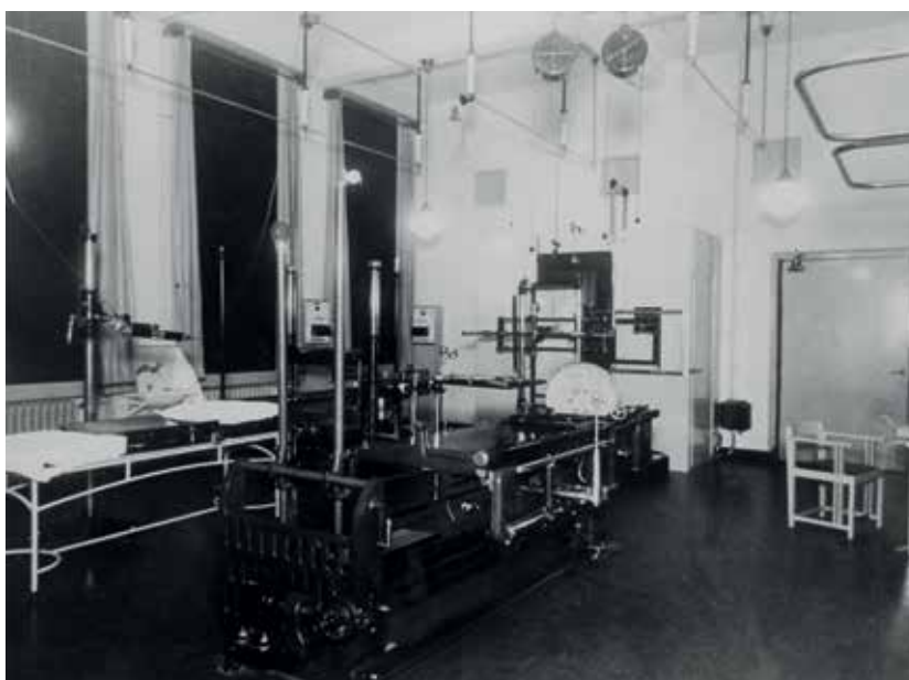
Figuur 2. Onderzoekruimte met drie statieven. Links een zuil met een Metalix type D röntgenbuis en een eenvoudige onderzoektafel met Bucky-Potter-rooster, en achteraan een thoraxstatief waarvan het doorlichtscherm in hoogte versteld kan worden dankzij de katrollen aan het plafond. Op de voorgrond het universele maagdarfstatief Table Radiographique Oscillante van Gaiffe, Gallot & Pilon. Aan het plafond de leidingen met de lange isolatoren.
