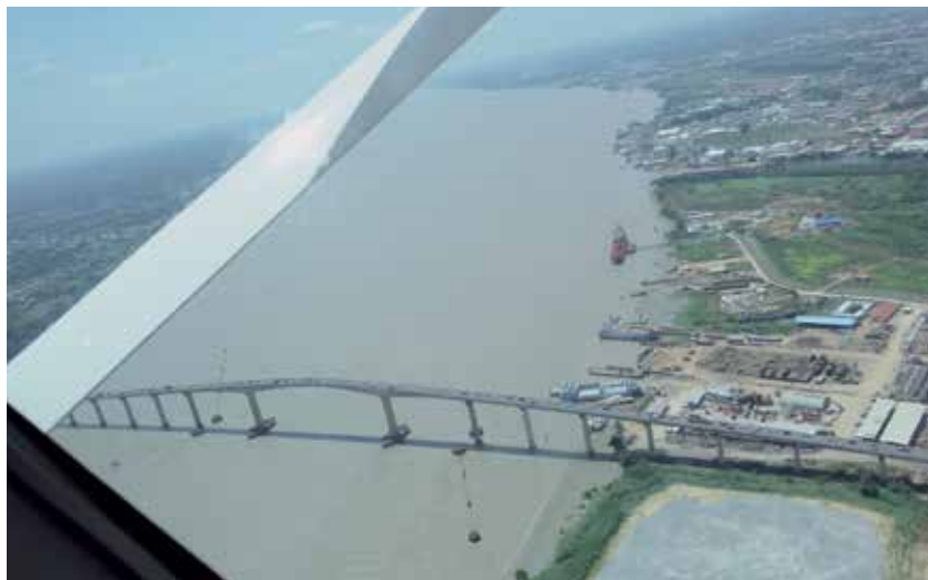
Ik vlieg met mijn dochter Palameu in het zuiden. Kort na het opstijgen ligt onder ons de Wijdenboschbrug over de Surinamerivier.
