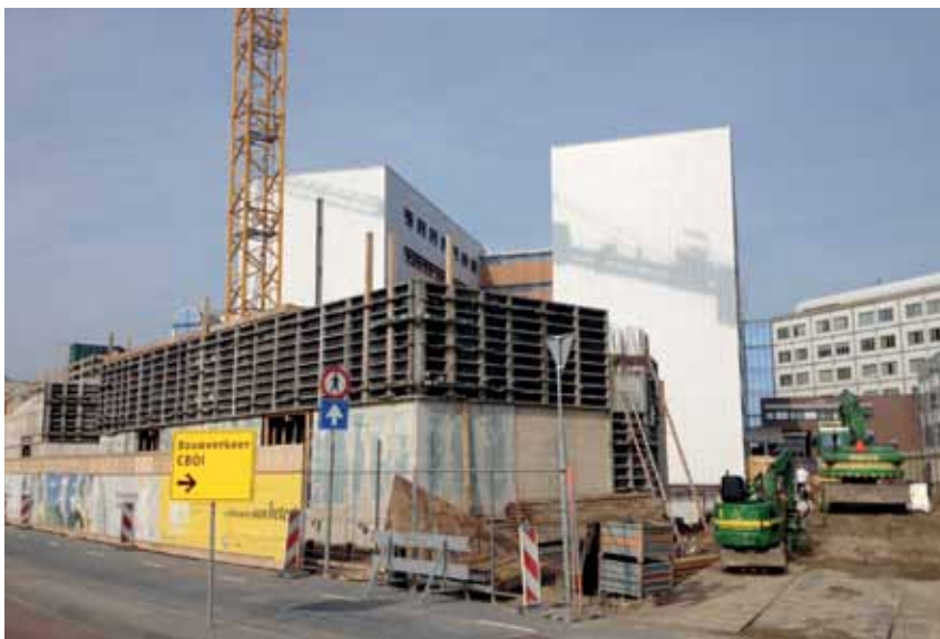
Figuur 2. Het Centrum voor Beeldgestuurde Oncologische interventies van het UMC Utrecht in aanbouw.
